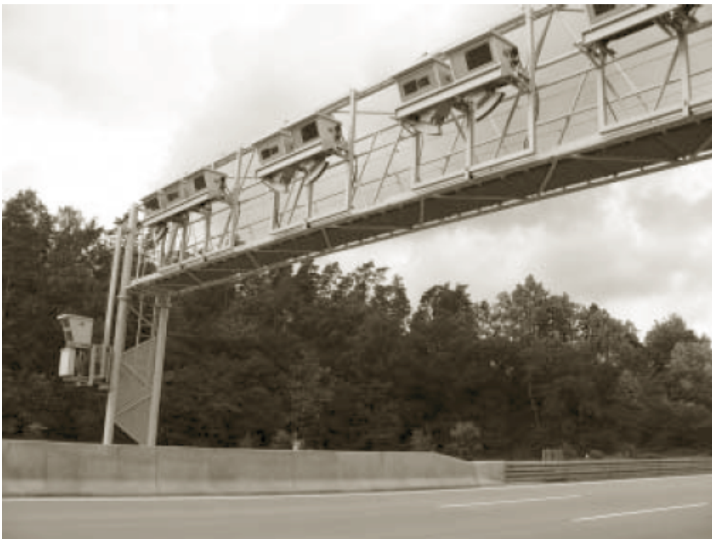
Abbildung: Autobahn-Mautbrücke (aus: 20. Tätigkeitsbericht des BfD, S. 180)
